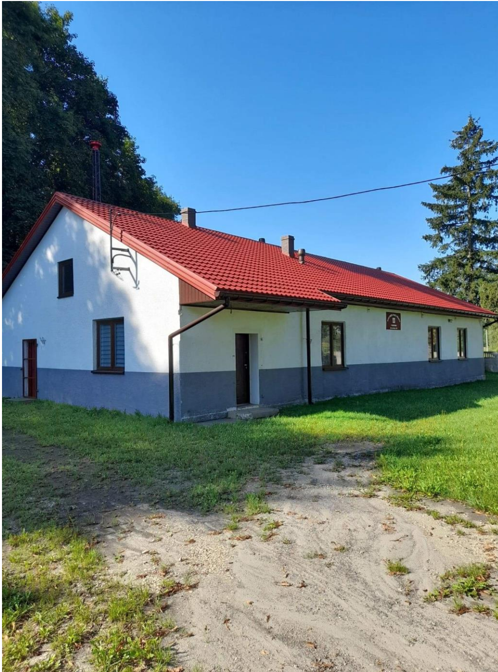
Remont i modernizacja dachu świetlicy wiejskiej w Borzykówce
